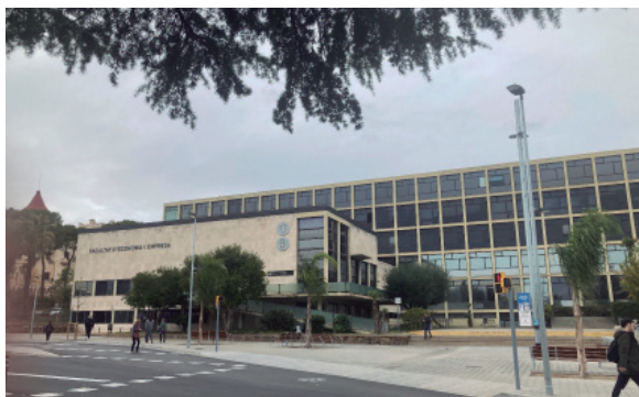
Edifici de l'Escola d'Alts Estudis Mercantils, que va acollir els estudis de Psicologia a partir del 1971.
